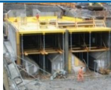
Entsanderanlage Burglauenen im Bau
