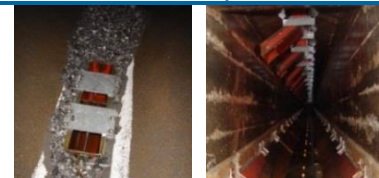
Vollständig ausgeräumter Entsander nach der Spülung
