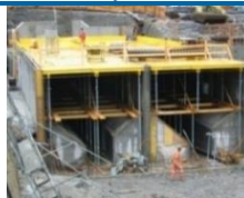
Déssableur Burglauenen en construction
