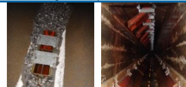
Déssableur complètement vidé après la chasse d'eau
