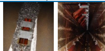
Canal de evacuación completa después del lavado
