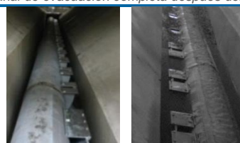
Tubo de salida en la puesta en marcha (izquierda) y después un año y medio más tarde, después de enjuague exitoso (derecha)
