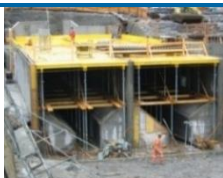
Desarenador planta Burglauenen en construcción
