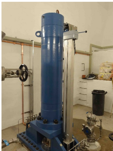
Modules de mesure vidange de fond avec boîte à étoupe
