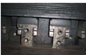
Revision Generatorhammerköpfe Pumpspeicherkraftwerk
