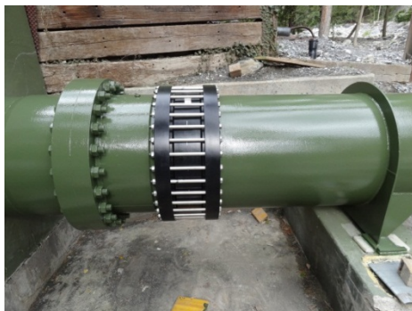
Dilatation Druckleitung nach Erneuerung
