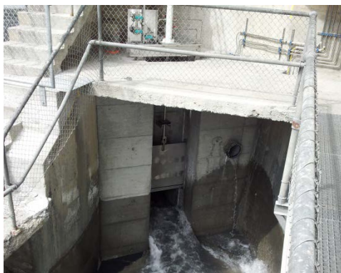
Neuer Einlaufschütze in den Entkieser
