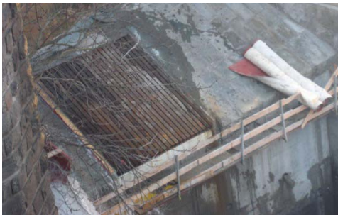
Neues Tirolerwehr im Bau
