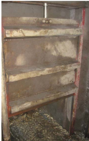
Alter elektrischer Schieber
