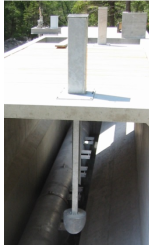
Sedimentmessung Entsander
