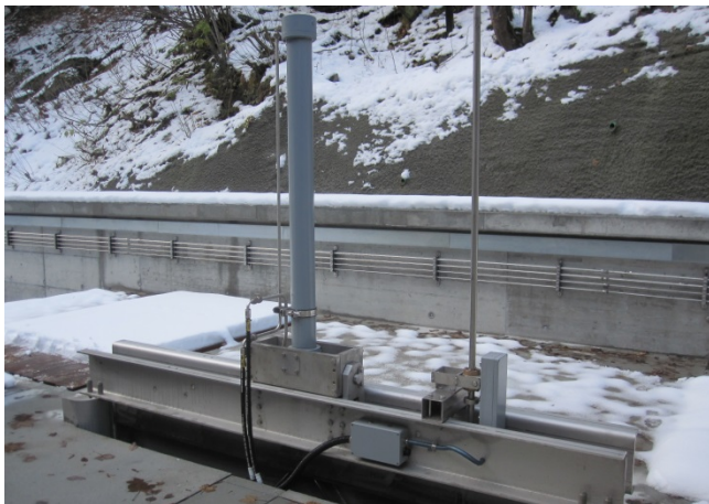
Joch Einlaufschütze mit Zylinderaufhängung & Endschaltermodul
