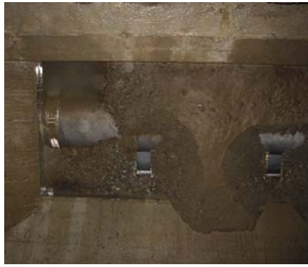
Bild 5. Typischer Resthaufen bei Normalspülung.
