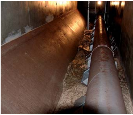
Bild 4. Hydraulisch optimierte Form.
