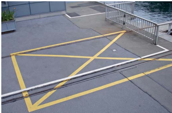
Bild 6. Definierter Instandhaltungsplatz, um rundherum Arbeiten an der Maschine sicher durchführen zu können.
