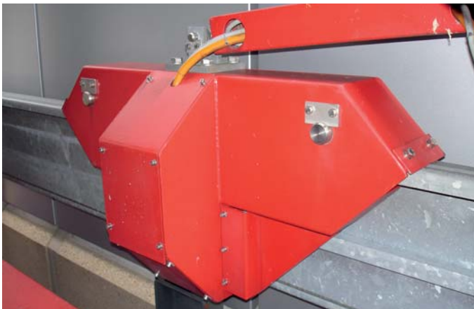
Bild 5. Messwagen für die absolute Wegmessung inkl. Endlagenüberwachung.
