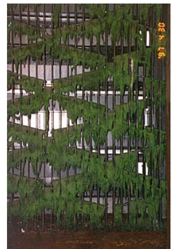
Abb. 3 Grosse Rechenverluste durch Verstopfung an den Quertraversen
