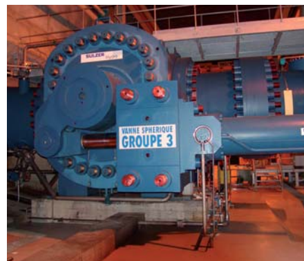
Bild 19. Kugelschieber Bieudron.
