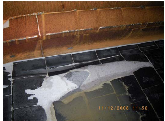
Bild 4. massiver Verschleiss an aufwändiger Basaltpanzerung.
