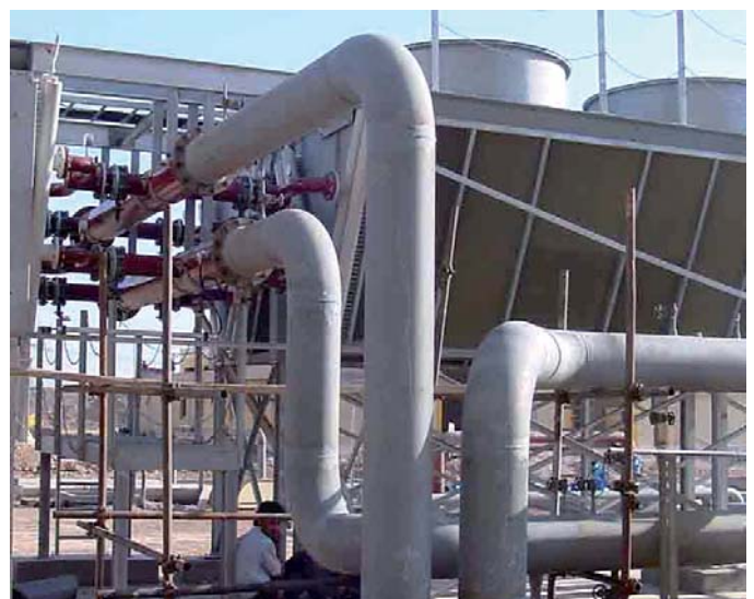
Bild 10. Verrohrung Assalouyeh Power Plant.
