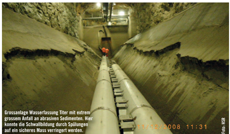
Typische Ausrüstung Wasserfassung Kleinwasserkraftwerk mit Abzugrohr, Sedimentmessung und Spülschieber
